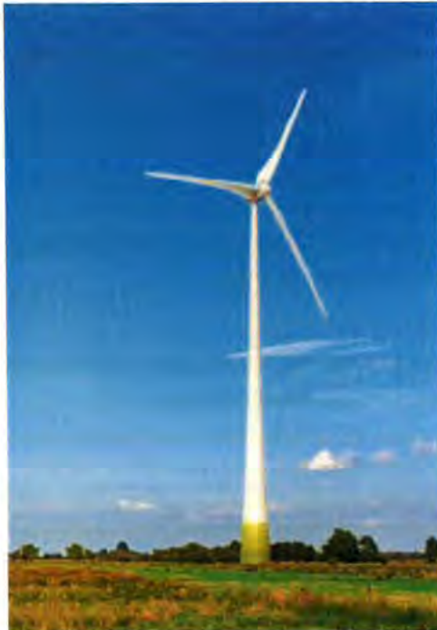
Klasse 3-5 MW (afgebeeld type: Enercon E-82; 3 MW)
