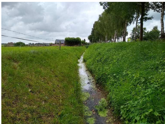
Foto 7: Foto waterbodem vak 1
