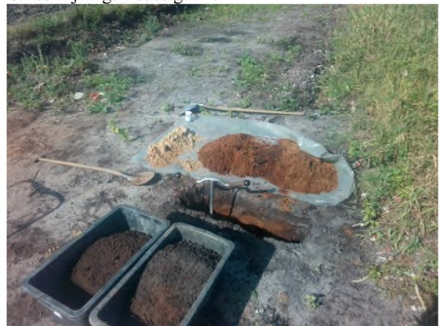
Fotonummer: 6 Omschrijving: Sleuf 01
