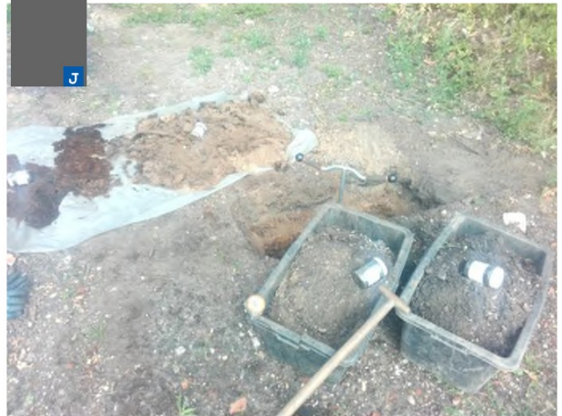
Fotonummer: 20 Omschrijving: Sleuf 05
