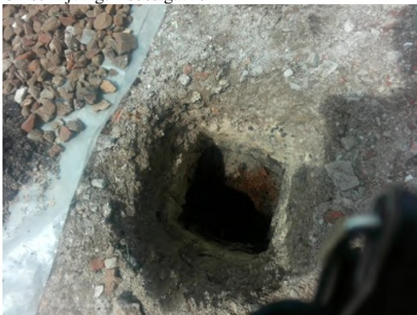
Fotonummer: 3 Omschrijving: Maaiveld inspectie
