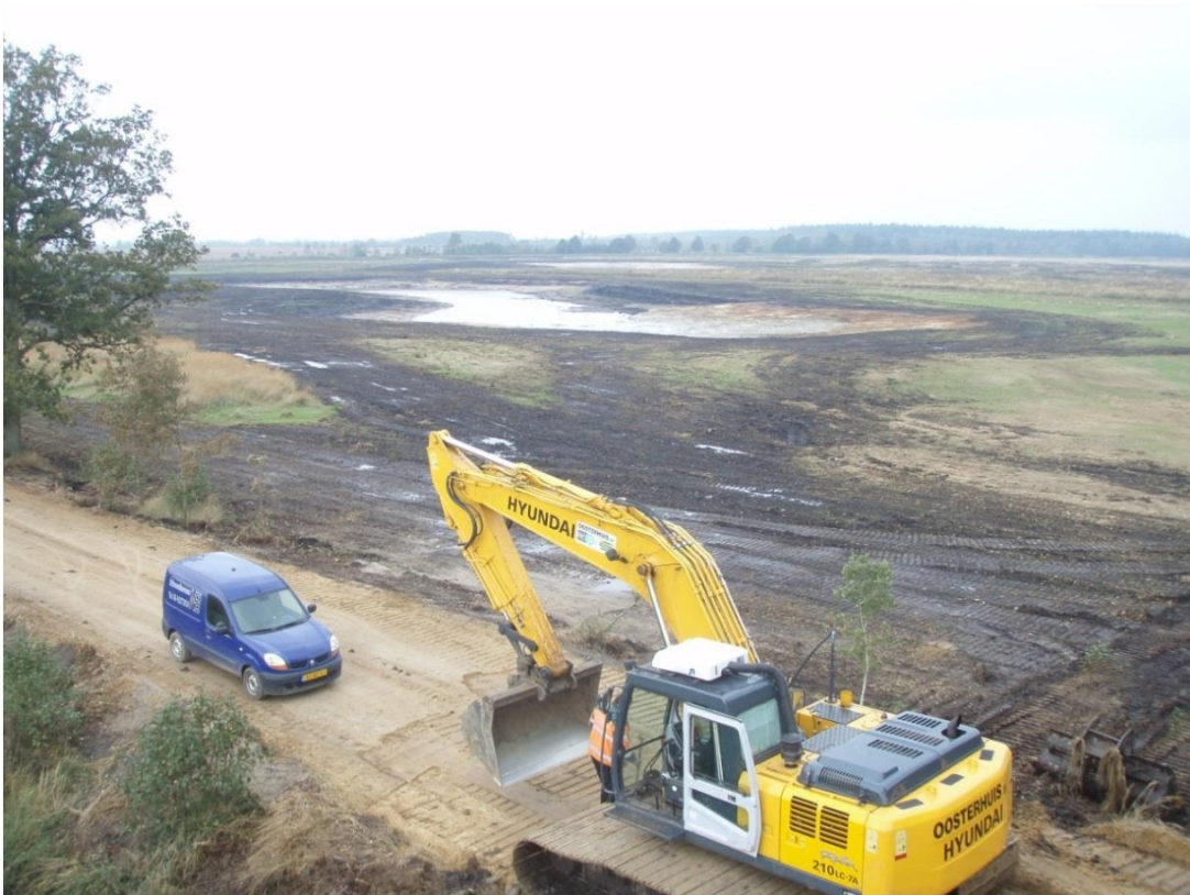
Figuur 5 Overzicht Stallaangebied oktober 2013, gezien vanaf de uitkijktoren.
