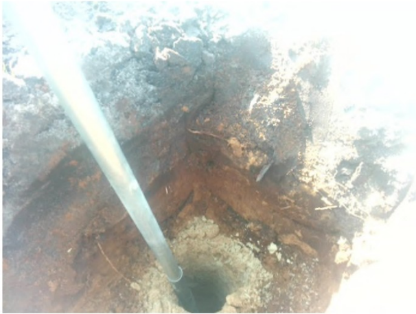
Fotonummer: 7 Omschrijving: Sleuf 01
