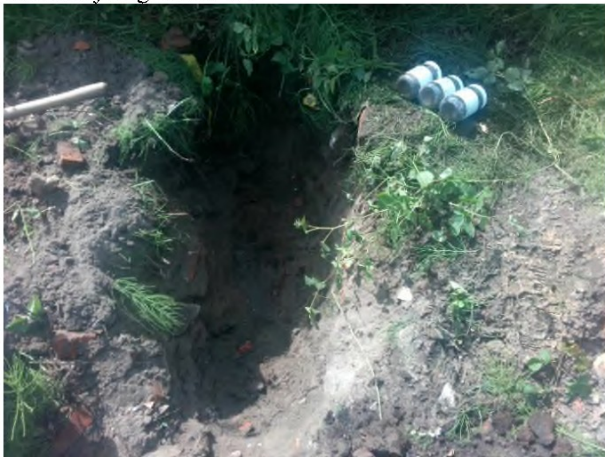
Fotonummer: 17 Omschrijving: Sleuf 04
