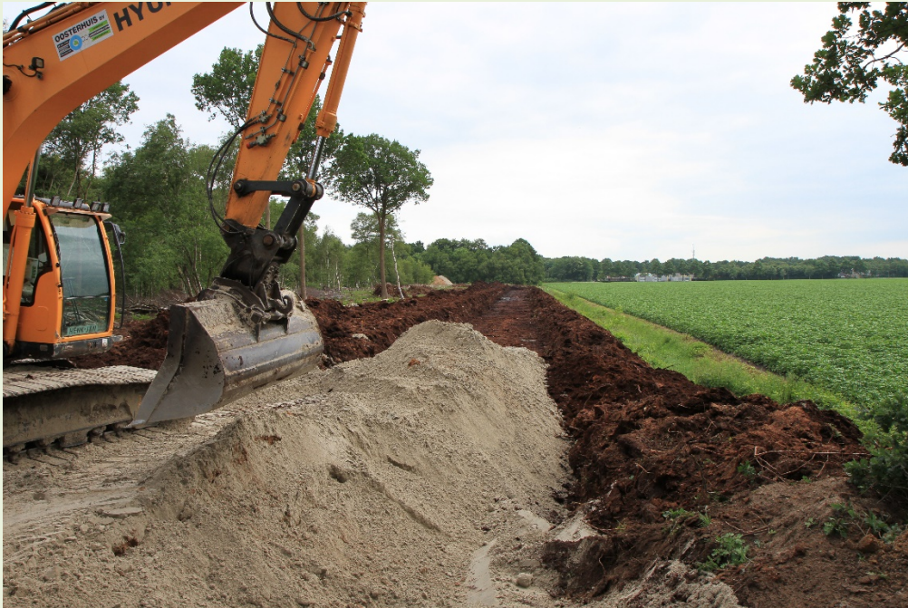
Figuur 3 Graafwerkzaamheden voor de aanleg van buffer West bij Weiteveen
