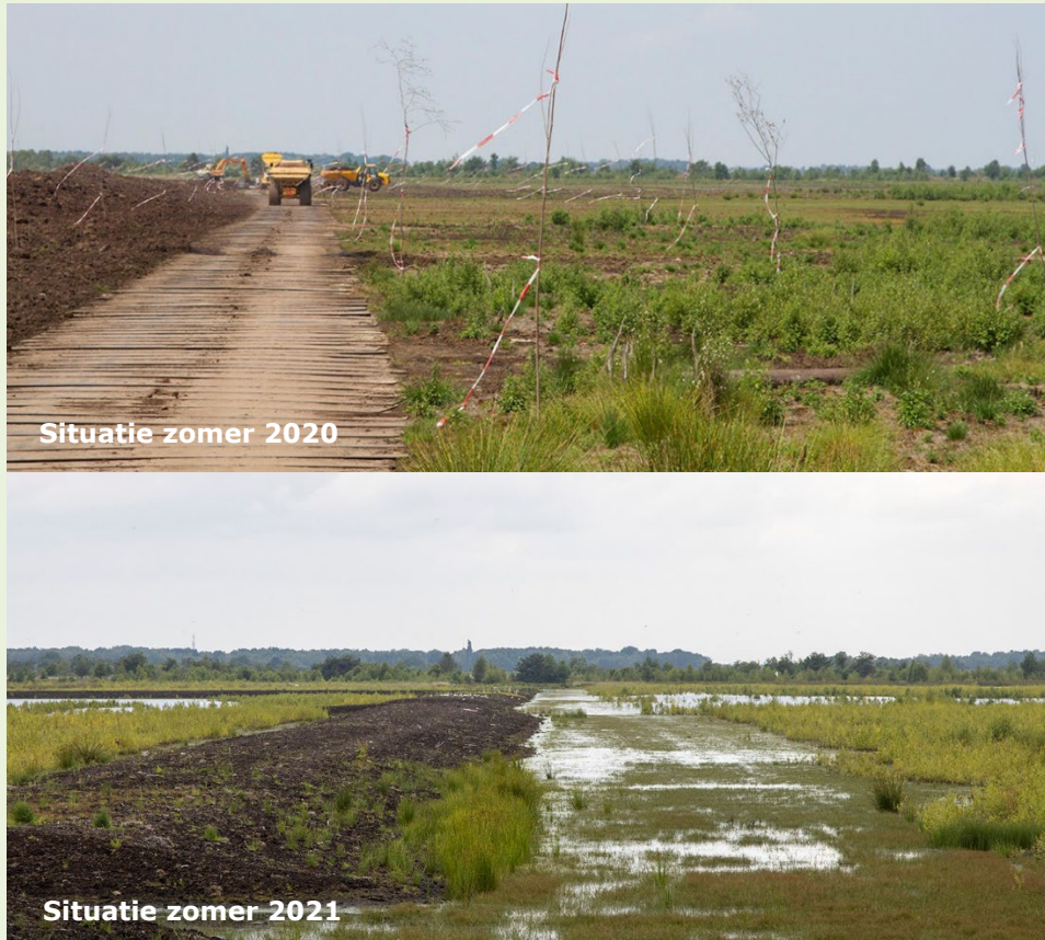
Figuur 2 De situatie tijdens en een jaar na de werkzaamheden aan compartimentering ten behoeve van hoogveenontwikkeling in het Amsterdamsche Veld
