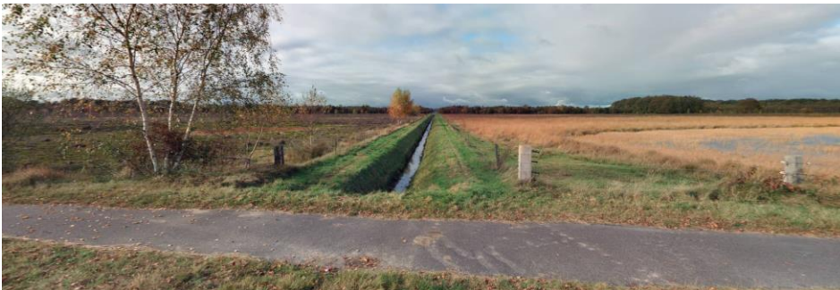
Figuur 2.19 Hoofdwaterring gezien vanaf de zandweg Haarweg met fietspad in de richting van de Hullenraai met aan weerszijden een verhoogd onderhoudspad
