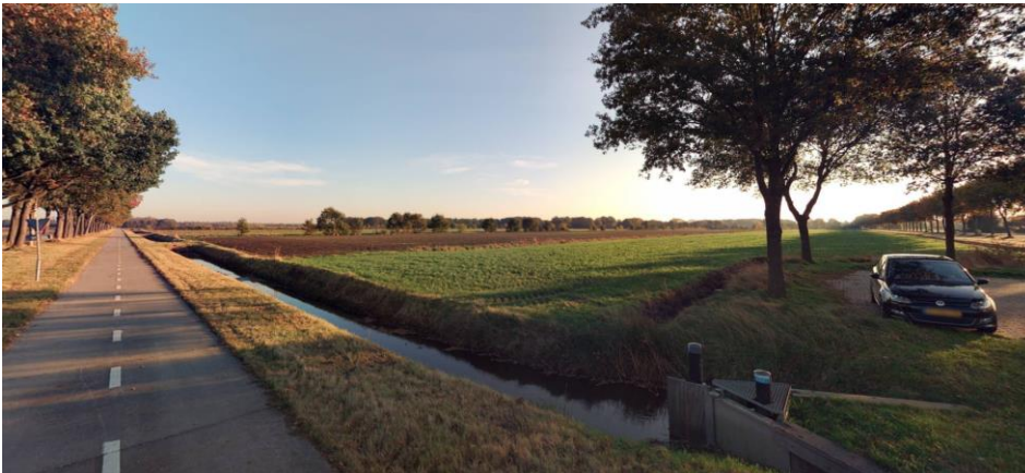
Figuur 2.12 Bermsloot langs N374 met knijpstuw MV221S1 bij de carpoolplaats
