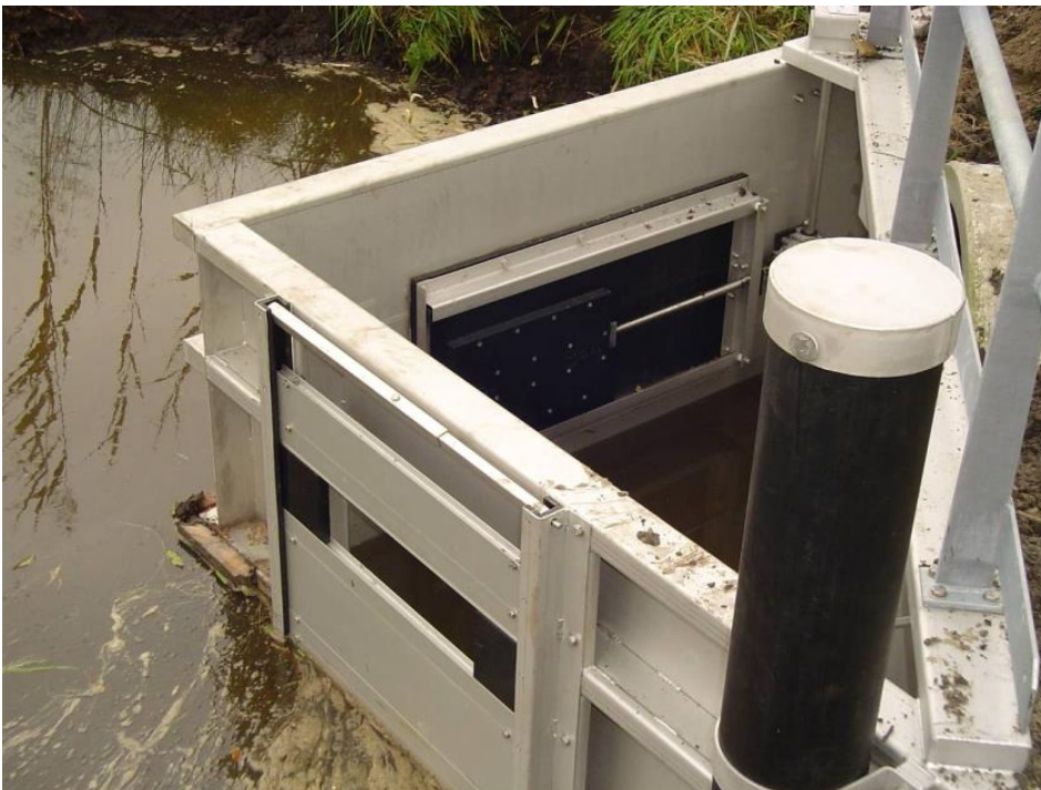
Figuur 3.2 Geplaatste WB21-stuwbak met doorstroomgat (voorzijde), spindelafsluiter (achterzijde) en WB21-overstortrand (bovenzijde driehoek)
