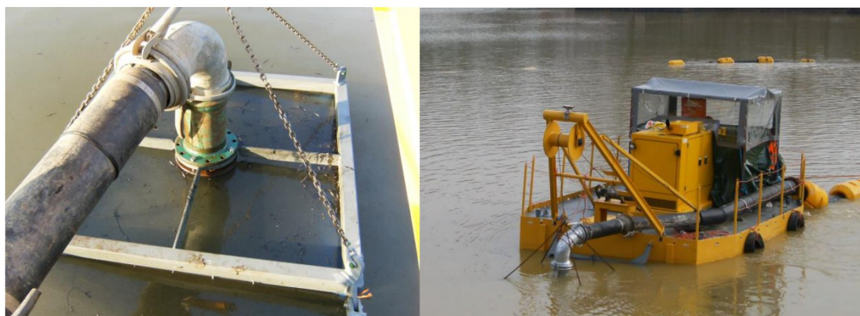
Figuur 3.2: zanddiffuser (links), met ponton voor opspuiten van het talud (rechts)
