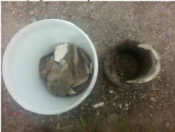
Fotonummer: 5 Omschrijving: Maaiveld
