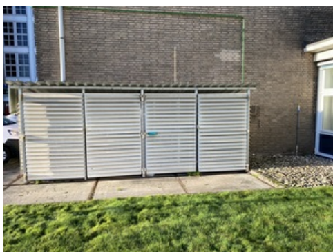
Bijlage_5_Gasflessen_opslag_lab foto gemaakt door 5.1.2.e (RUD) op 20 december 2021
