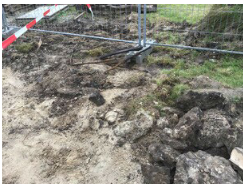
Foto d.d. 14-09-2021 door 5.1.2.e, toezichthouder bodem RUD. De klonten op de foto zijn grond vermengd met verweerde/uitgeharte olie. Links daarvan is in het spoor ook nog her en der olie zichtbaar, onder andere in het ballastbed.
