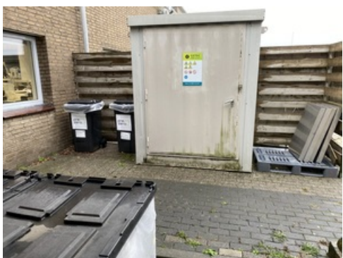
Brandwerende_kast_buitenopslag gemaakt door 5.1.2.e op 17 oktober 2022 5.1.2.e (op 06 december 2022 12:23)
