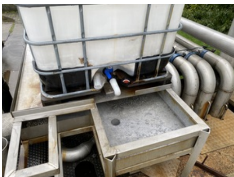
opvangconstructie_tijdelijke_IBC AWZI gemaakt door 5.1.2.e op 17 oktober 2022 5.1.2.e op 06 december 2022 12:22)
