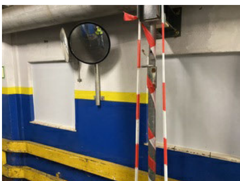
Raam_dichtgemaakt gemaakt door 5.1.2.e op 17 oktober 2022 5.1.2.e op 06 december 2022 12:22)
