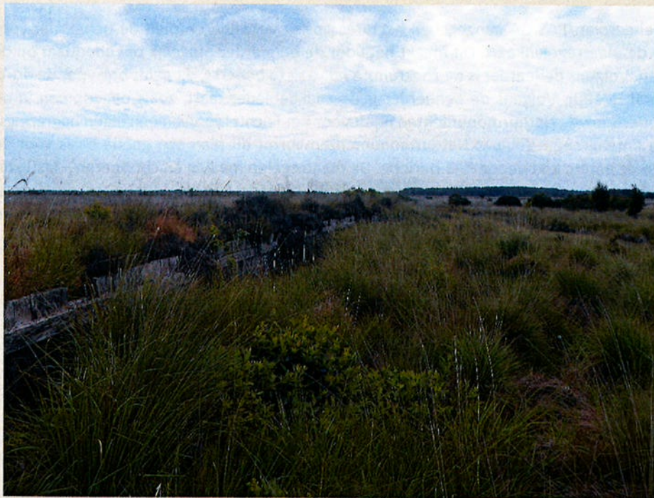
Figuur 4. De houten delen van de kades zijn vaak bloot komen te liggen en zijn deels gaan rotten. Hierdoor ontstaan lekkages.
