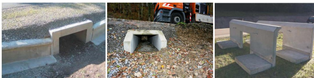
Figuur 6.2 Voorbeelden van kleine faunatunnels vlak onder het wegdek en rechts een frontmuurtje. Bron: Maibach, 2023
