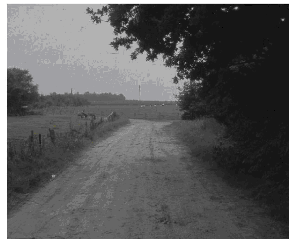
Zandweg (later verhard) richting es Schier (foto 1981, Drents archief, collectie DLG, LG0408140)
