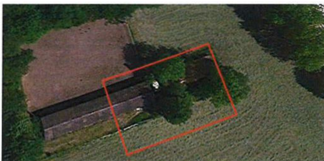
figuur 1: terreindeel t.p.v. geplande nieuwbouw
