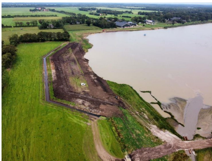
Figuur 2.2: tijdelijk verlegde kade en randstrook ter plaatse van de bres
