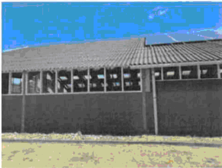
6 aug. 2020: ligboxenstal met open zijgevels
