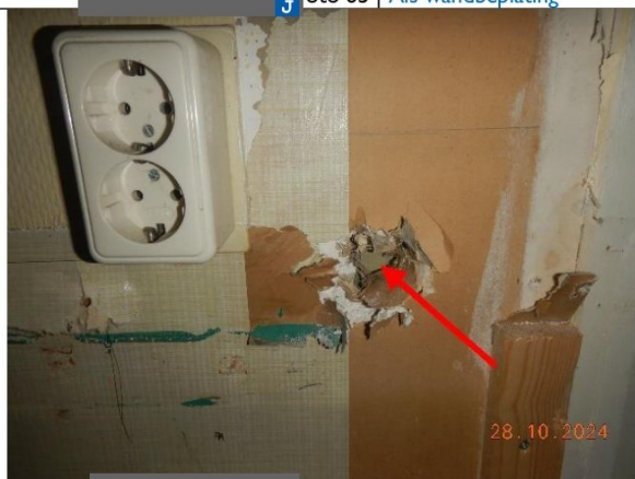
J Foto 67 | Als wandbeplating
