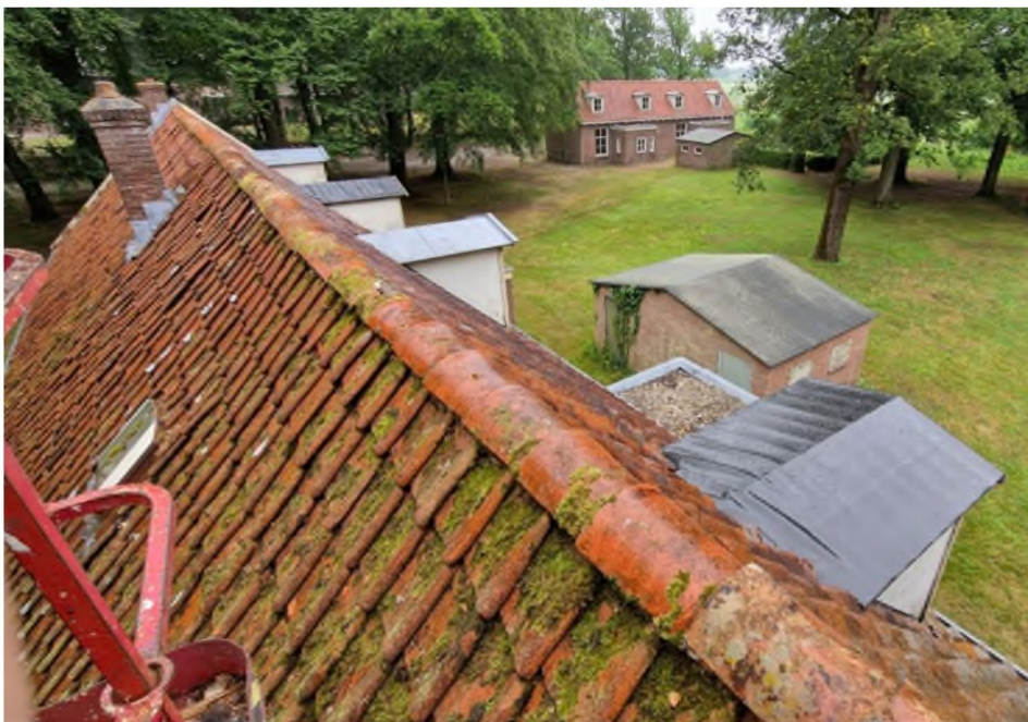
Het dak van E-F in 2022. Foto: DnR
