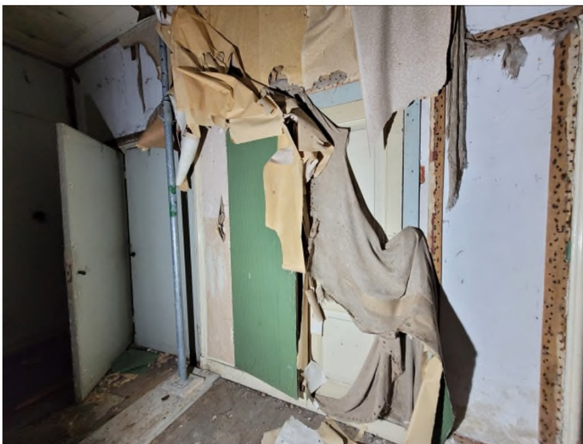
Dezelfde wand in woning F met hier nog de oudere deuren
