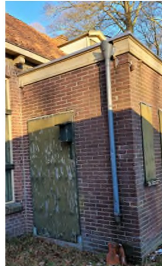
De binnen gevel bij aanbouw F
