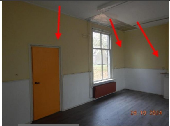
J Foto 64 | Als wandbeplating
