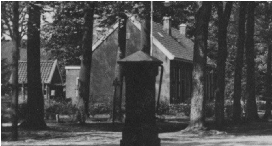
Woningen B en A van het eerste plantsoen in 1952. De dakkapellen lijken al aanwezig en de aanbouw heeft al de huidige vorm. Bron: Drents Archief, uitgever Fa. B. Rouppé, VGO201016
