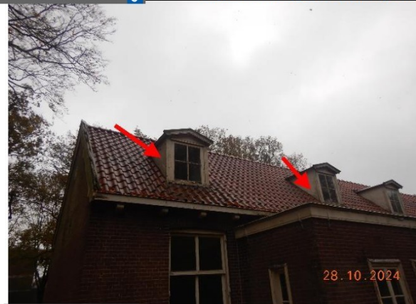
Foto 48 | Zijkanten 'wangen' van dakkapellen
