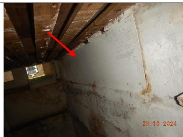
J Foto 20 | Als wandbeplating
