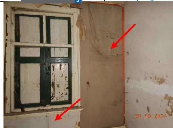
J Foto 22 | Als wandbeplating
