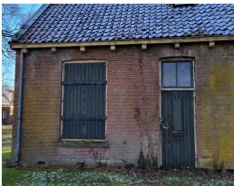
Een van de vensters en de voordeur van woning F
