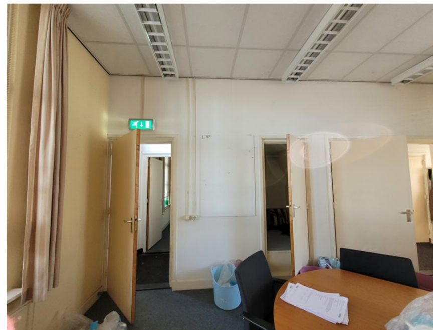
De voormalige woonkamer in B met links de deur naar de voormalige keuken, dan de deur naar de bedstede, de deur naar de kelder en tot slot de deuropening naar de hal
