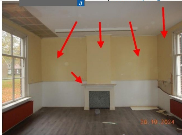
J Foto 65 | Als wandbeplating
