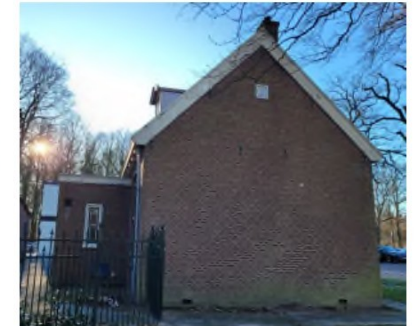
De linkergevel van N-O
