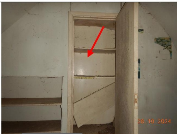
J Foto 25 | Als wandbeplating
