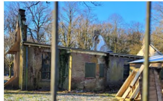
De achtergevel van I-K
