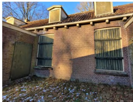
Twee van de vensters in de achtergevel
