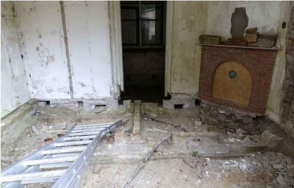
De hoekschouw in woning I. Bron: Chantal van der Ende
