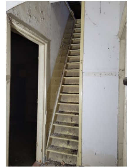
De trap naar zolder in woning F
