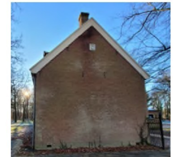
De rechtergevel van C-D
