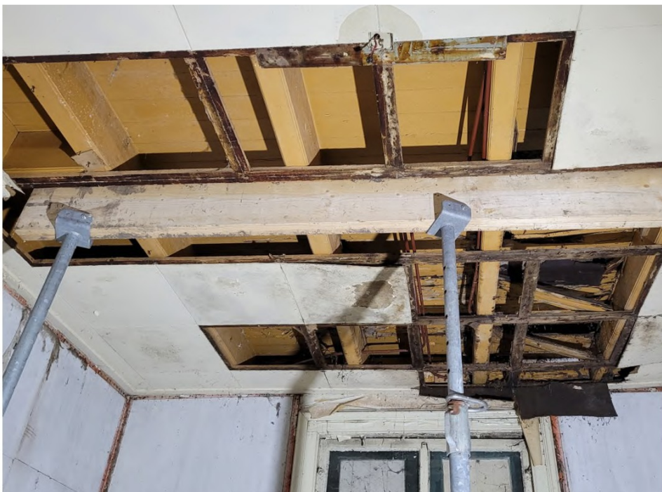
De balken met een bescheiden profiel en daarboven de houten vloerdelen in woning F
