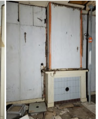
De schouw in de woonkamer van F
