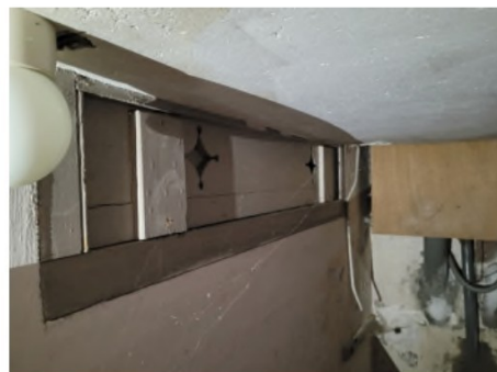
De zijwand van de bedstede is nog zichtbaar in de kelder in woning A
