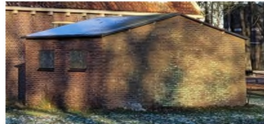
De achtergevel van de schuur
