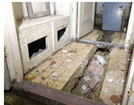
De vloer van de hal en daarachter de vloer van de douchcel in woning I. Bron: Chantal van der Ende
