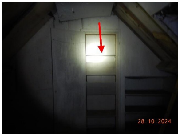
J Foto 24 | Als wandbeplating
