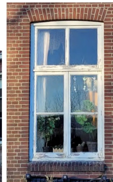
Het later toegevoegde venster in de zijgevel bij woning H met strekken en drieklezoren in de negge.
