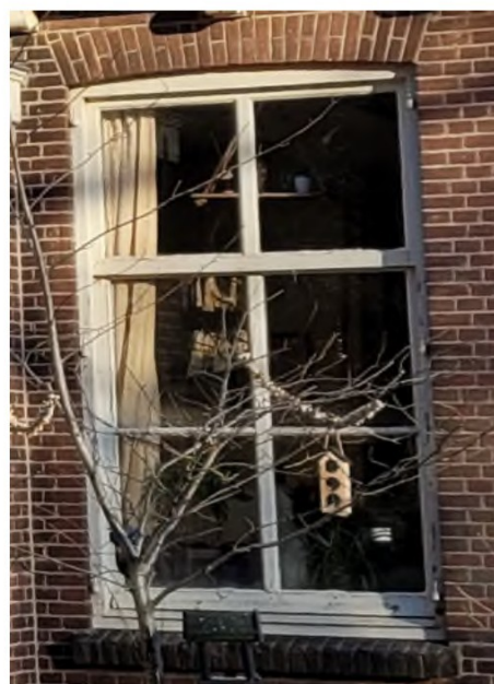
Het zesruits schuifvenster in de achtergevel bij woning H
