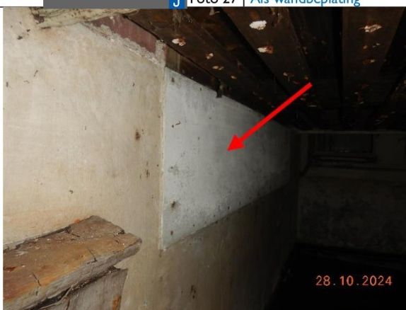
J Foto 29 | Als wandbeplating
