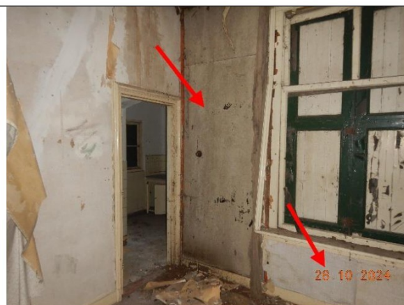
J Foto 21 | Als wandbeplating
