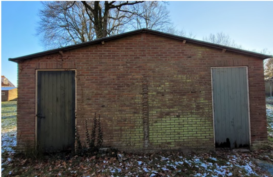
De voorgevel van de schuur van E en F. Hier is in het midden goed het spoor van muur tussen beide tuinen zichtbaar
