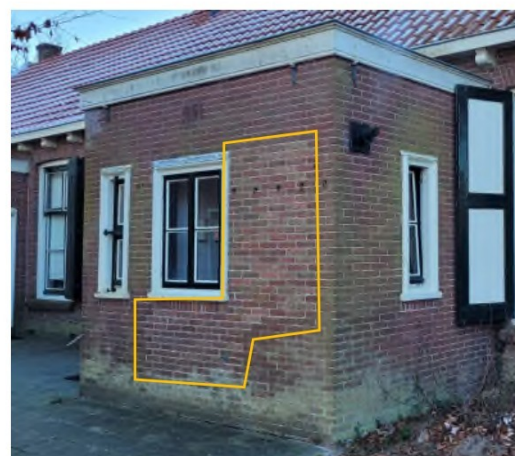
Metselwerk in een enigszins afwijkende kleur met nieuwer voegwerk in de achtergevel van de aanbouw van woning L
