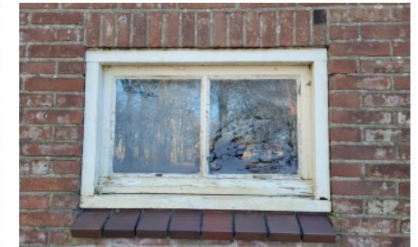
Een van de twee schuurvensters van woning G
