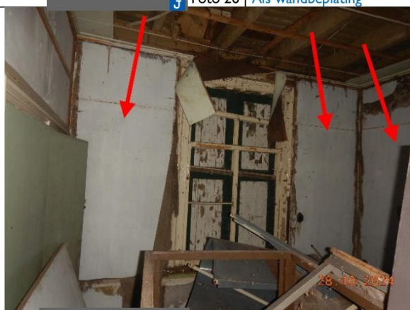
J Foto 28 | Als wandbeplating
