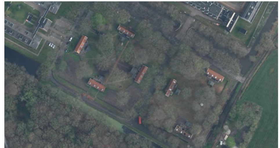
Luchtfoto uit 2023 van de woningen. Het dak van blok K-I Oude Asserstraat 6 en 8 is hier nog deels aanwezig
