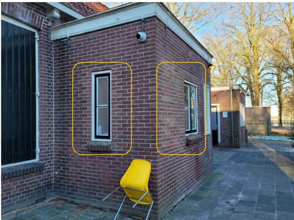
Bij woning N is bij de aanbouw het venster in de buitengevel en het brede venster in de achtergevel vervangen. Rondom het venster is nieuwer metselwerk zichtbaar, de kozijnen zijn eenvoudiger en beide vensters hebben een gemetselde onderdorpel. Het brede venster heeft daarnaast een rollaag boven het venster
