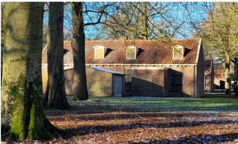
De achtergevel van E-F met daarachter C-D en N-O
