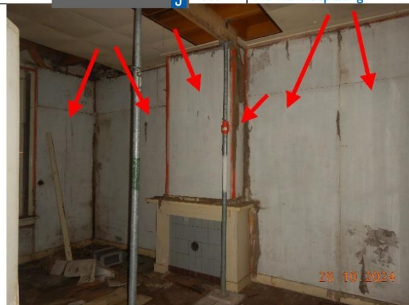
J Foto 23 | Als wandbeplating
