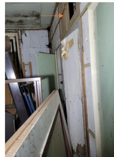
In woning E is nog de bovenkast boven de bedstede in de woonkamer aanwezig
