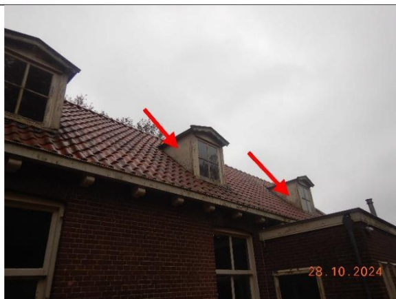
Foto 47 | Zijkanten 'wangen' van dakkapellen
