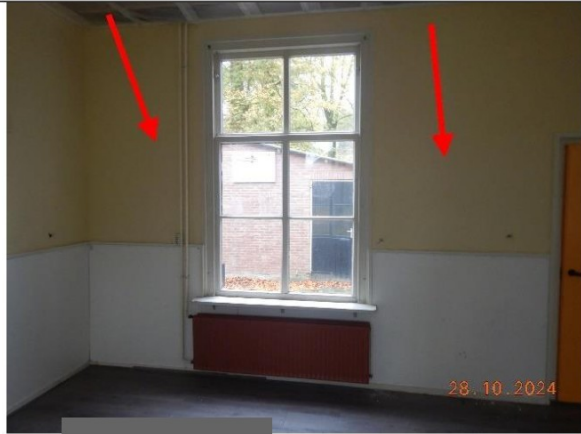
J Foto 63 | Als wandbeplating
