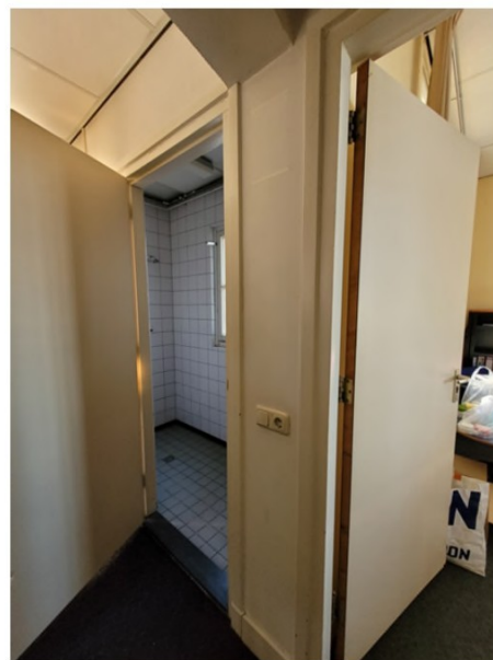
De toegevoegde rechthoekige ruimte tegenover het toilet in de voormalige keuken
