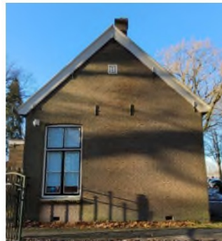
De linkergevel van A-B
