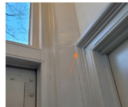
De kozijnstijl in de hal van woning D is nog wel intact
