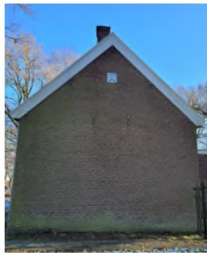
De rechtergevel van A-B
