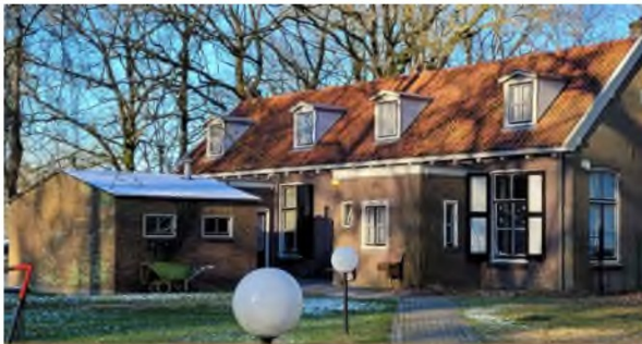
De achtergevel van A-B
