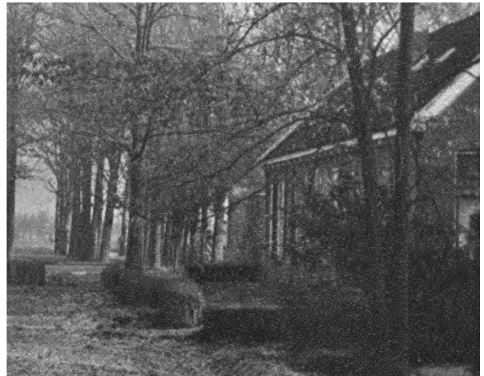
Woningen N en O tussen 1950-1965. N heeft hier het venster in de zijgevel. Bron: Drents Archief, collectie gevangenis museum, VGO101064
