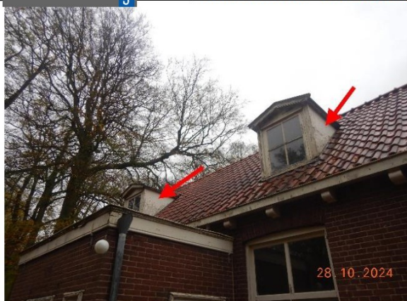
Foto 49 | Zijkanten 'wangen' van dakkapellen
