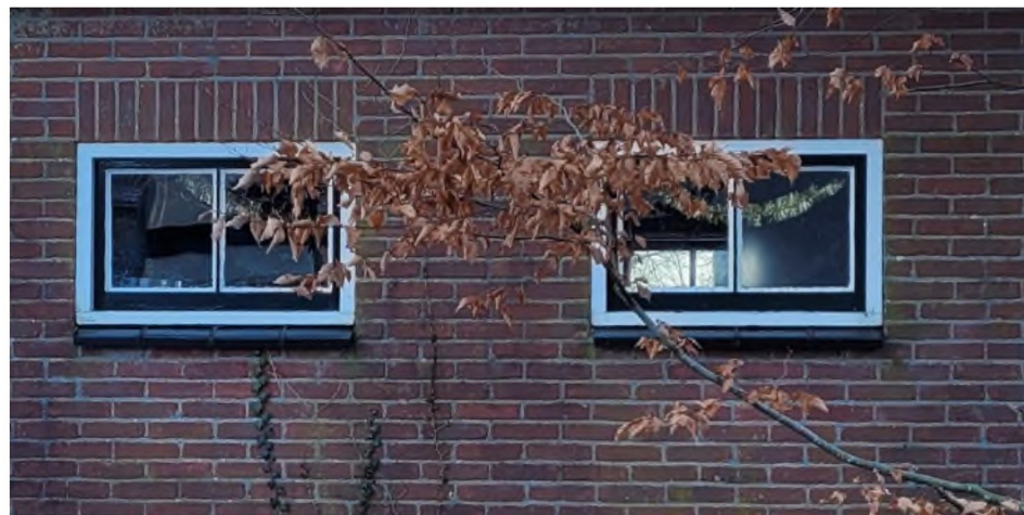
De hogere rollaag en zwarte in plaats van bruine keramische onderdorpels bij het schuurtje van M
