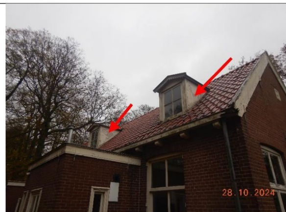
Foto 46 | Zijkanten 'wangen' van dakkapellen
