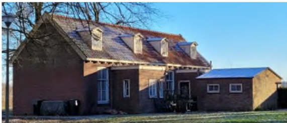
De achtergevel van G-H
