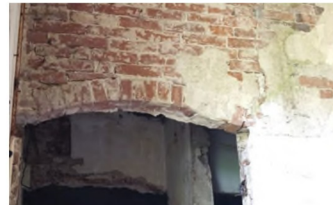
De segmentboog boven de doorgang naar de keuken in K of I. Bron: Chantal van der Ende
