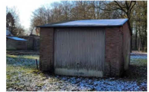
De linkergevel van de schuur
