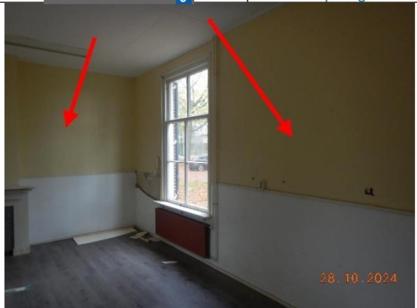
J Foto 66 | Als wandbeplating
