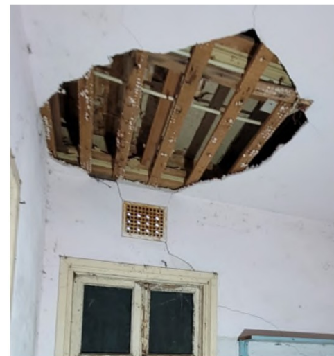
De constructie in de keuken van woning E
