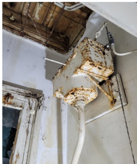
De gietijzeren stortbak in E
