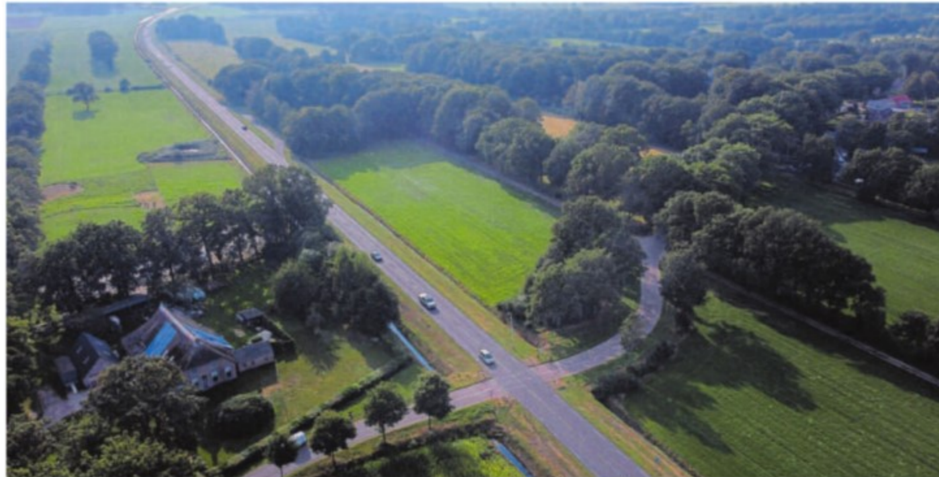
De twee gelijkvloerse oversteken over de N375 waar werkgroepen opteeden voor een landbouwtunnel. Boven de oversteek bij Gijsselte, onder de oversteek bij Berghuizen. FOTO'S JEROEN KELDERMAN
