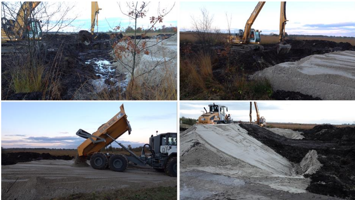
Afbeelding 5.3 Werkzaamheden aanleg proefkade
