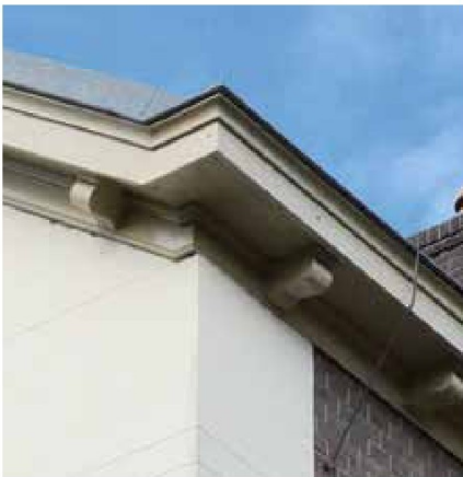
Toewijding / Hospitaalcomplex: de achterliggende geprofileerde gevellijst, tussen de gootklosjes, loopt door in de kopgevel. De gootklosjes zijn in beide gevels in het zicht.
