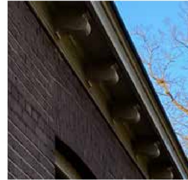
Gevellijst met gootklosjes en geprofileerde gootlijst.
