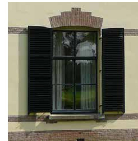
6-ruits schuifvenster, met persiennes die recht danwel gebogen zijn aan de bovenkant.
