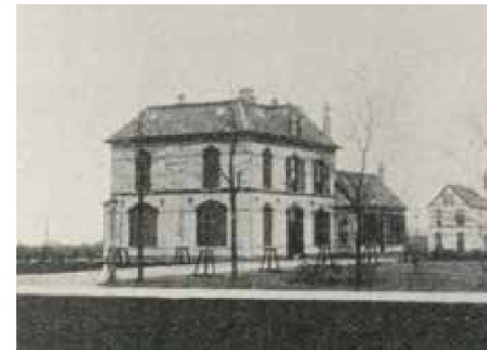
1903: De voormalige villa Excelsior, het huidige Directiehotel, was samen met de villa Ruimzicht op de hoek van de Kolonievvaart en de Generaal van den Boschweg volop in beeld. Bron: 1903_directiehotel_DrentsArchief_DM290002
