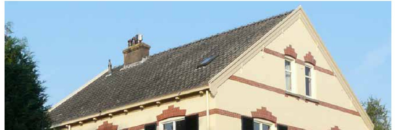
Gemetselde schoorstenen en keramische dubbel verglaasde schoorsteenpotten en -kappen. Foto JvdB
