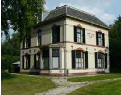
Directiehotel, voormalige villa Excelsior.
