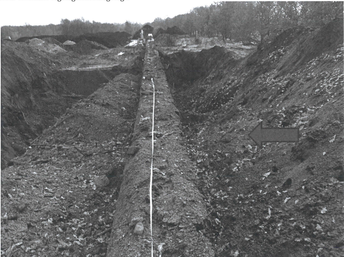
AEC-bodemas bovenop de legoblokken en tevens op de geluidswal
