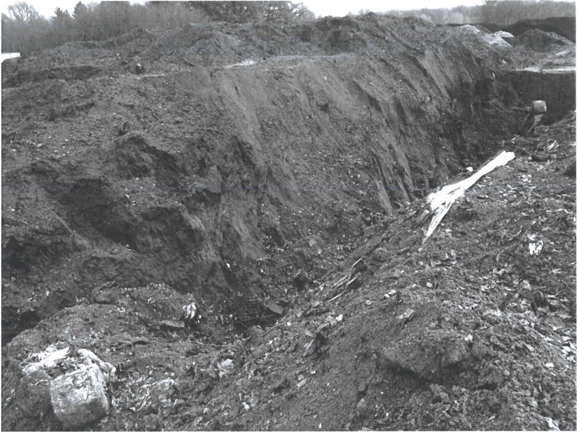
AEC-bodemas tegen grond aangelegd
