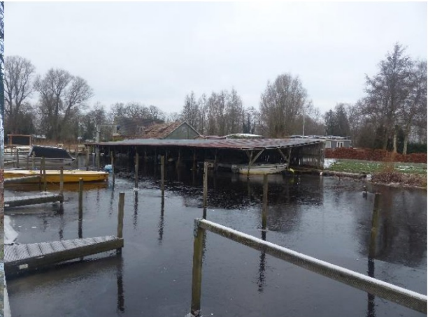
Foto 4 De haven met de meeste ligplekken en botenhuis buiten het plangebied.
