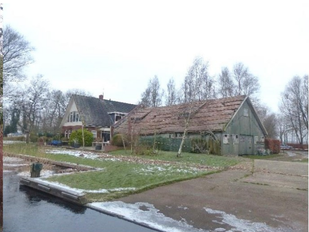
Foto 2 Het paviljoen en de grote bouwvallige schuur net buiten het plangebied..
