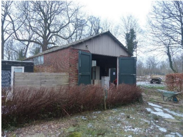
Foto 3 De lange smalle schuur buiten het plangebied..
