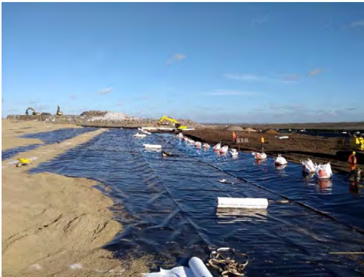
Aanbrengen folie, percolaatdrainage zand, doek voor grindkoffer
