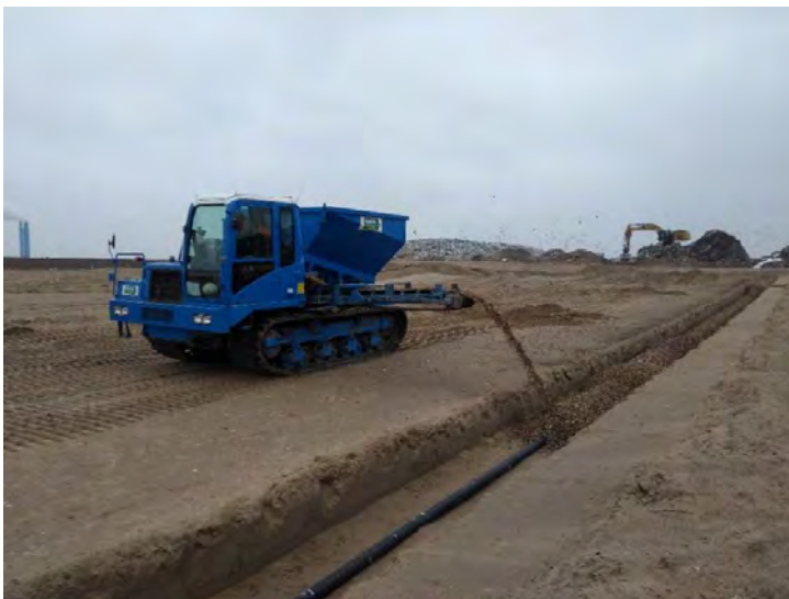
Aanbrengen grind t.b.v. grindkoffer rond percolaatdrain
