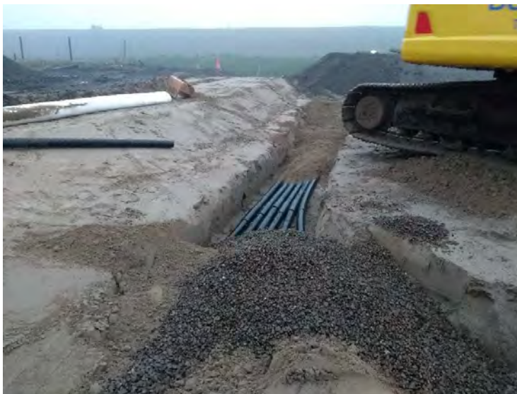
Bundel percolaatdrains langs kade tussen stortvak 5A fase 2 en 3
