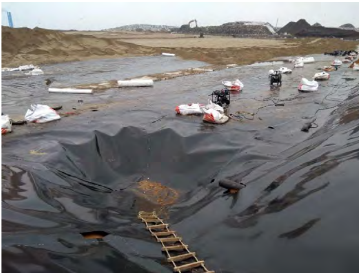
Verlaging in folie t.b.v. percolaat-afvoerput
