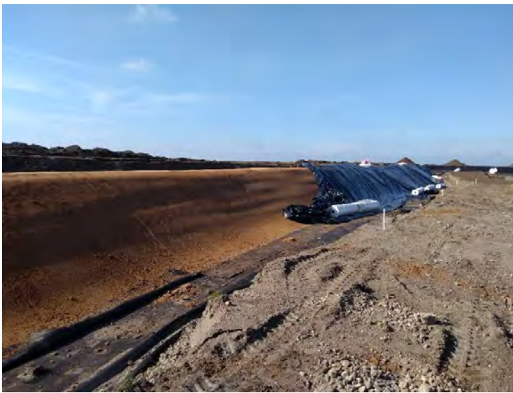
Aanbrengen trisoplast op zuidwestelijke kade met tijdelijke afdekking
