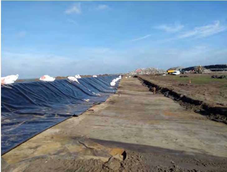
Aanbrengen folie op noordwestelijke kade, strook vrijgegraven trisoplast
