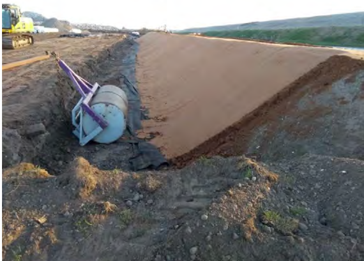
Aanbrengen trisoplast op kade langs Middenweg
