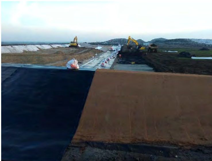
Aanbrengen foliebaan en percolaat-drainagezand
