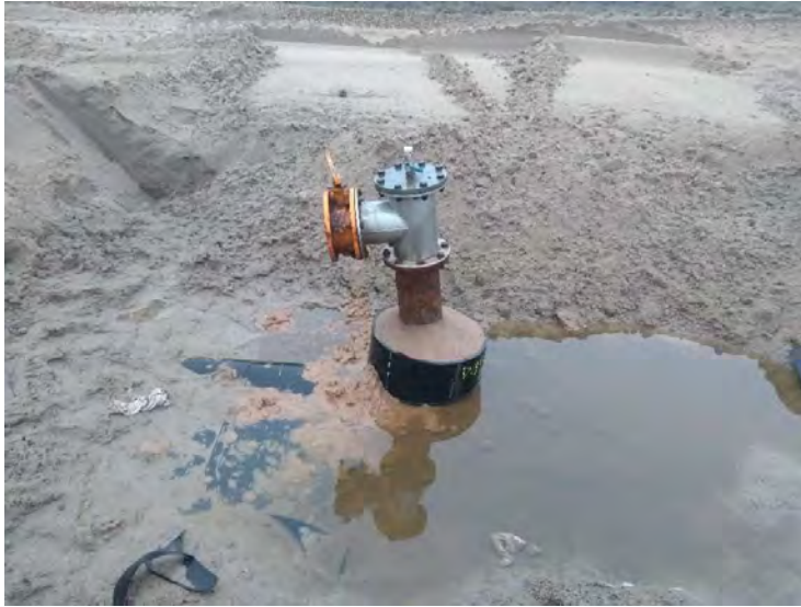
Afdichting doorvoeren gasbronnen met trisoplast
