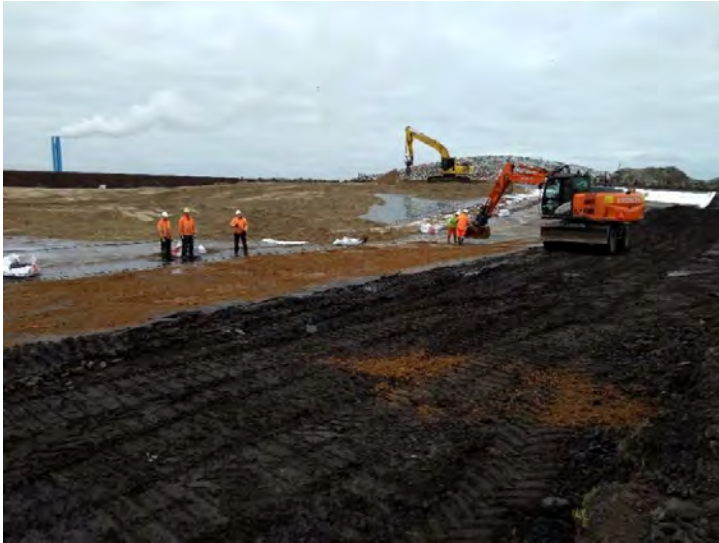
Herstel – reparatie trisoplastlaag
