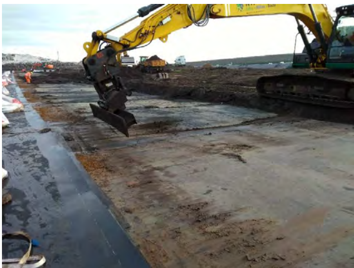
Vlakken trisoplastlaag met rubber flap aan stalen balk
