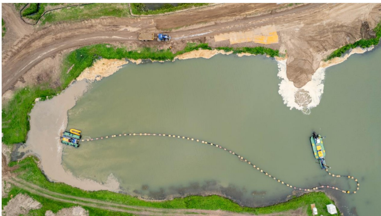
Figuur 4.1: impressie opspuiten talud met sproeiponton en cutterzuiger
