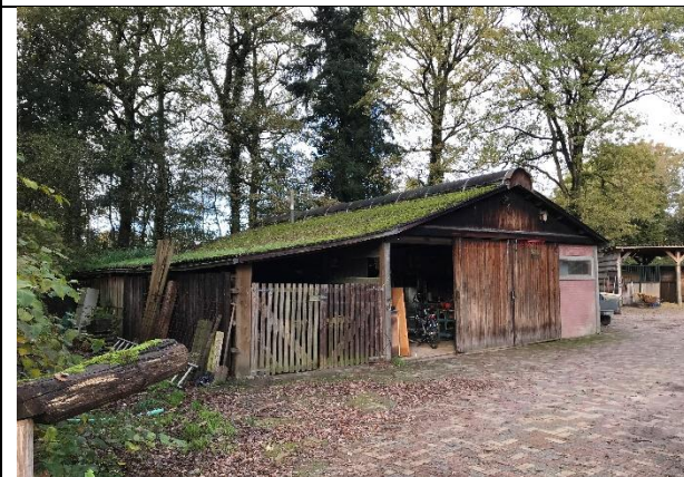
Afbeelding 2.3 gebouw voor beheer en onderhoud
