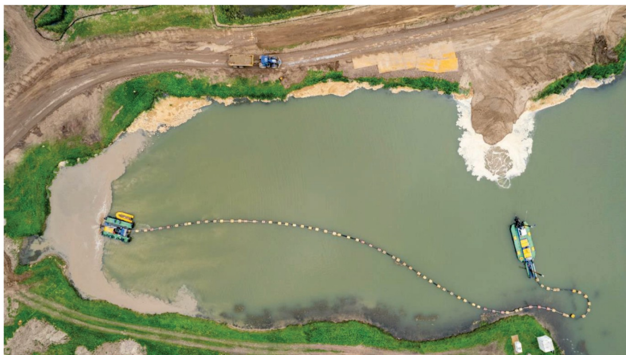
Figuur 4.1: impressie opspuiten talud met sproeioponton en cutterzuiger
