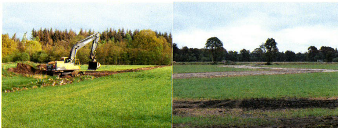
Figuur 1. In het kader van de Inrichting Oude Willem zijn in 2018 onder meer sloten gedempt en is een nieuwe meander ter vervanging van de Tilgrup gegraven. De maatregelen moeten bijdragen aan de verbetering van de hydrologische situatie.
